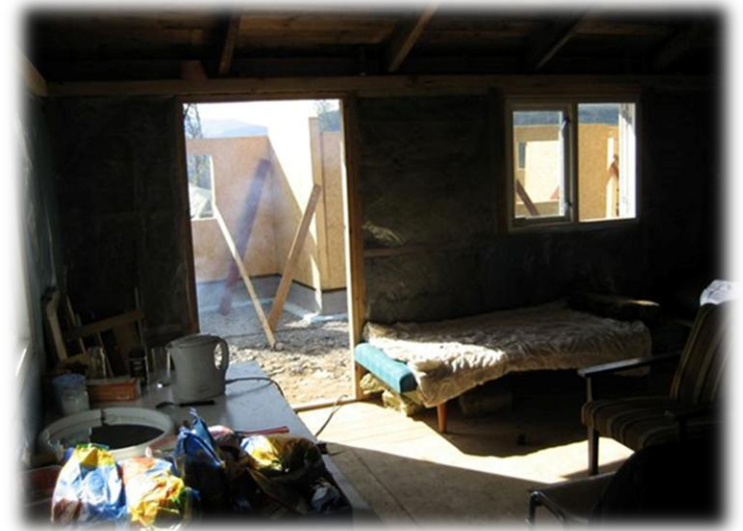
Innkvartering på byggeplass
