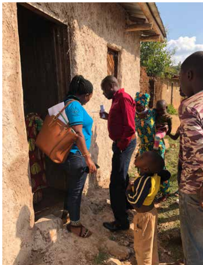
Batwafolket er omfattet av fattigdomsprogrammet. Det betyr at myndighetene setter opp hus til de mest vanskeligstilte. Men mange hus mangler vinduer og dører. Bildet er fra en inspeksjon som Coporwa utfører for å se om myndighetene leverer i henhold til avtalen.
